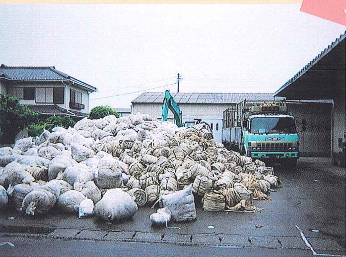
重機による運搬業者のトラックへ積み込み
