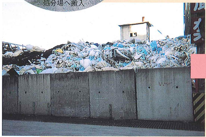
処分場の保管状況
